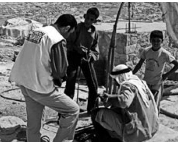
Rehabilitación de un punto de agua en Gaza. (Foto: Marçal Trigo).
