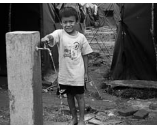
Uno de los puntos de agua rehabilitados por Acción contra el Hambre en un campamento de 400 familias instalado tras las inundaciones.
