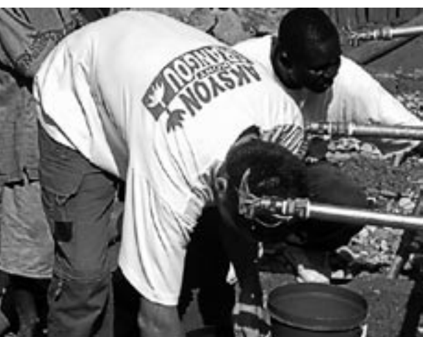
Rehabilitación y mantenimiento de uno de los puntos de agua en la capital del país, Puerto Príncipe.
