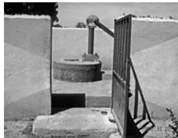
Construcción de un punto de agua.
