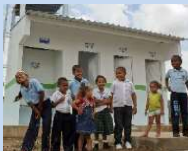
Rehabilitación sistemas de saneamiento básico en escuelas
